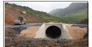
文麻2标全线第一条回填完成的钢波纹管 何超 摄
