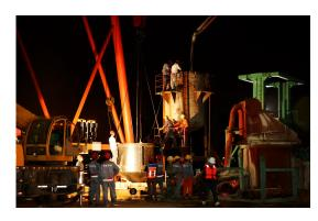
据悉,庞公大桥桩基成桩质量优良,现已 检测的 49 根桩基均为 I 类桩,合格率达 100%。 主桥桩基施工的完成,标志庞公大桥建设有了 实质性突破,项目全体员工将保持当前的良好 工作势头,为实现年内中主塔出水目标而努力 奋斗。(吴芊芊) 8月16日上午10时58分, 伴随着液压抓斗下放,襄阳庞 公大桥南岸锚碇地连墙基础首 槽开挖,标志着大桥锚碇主体 工程施工正式拉开帷幕。
