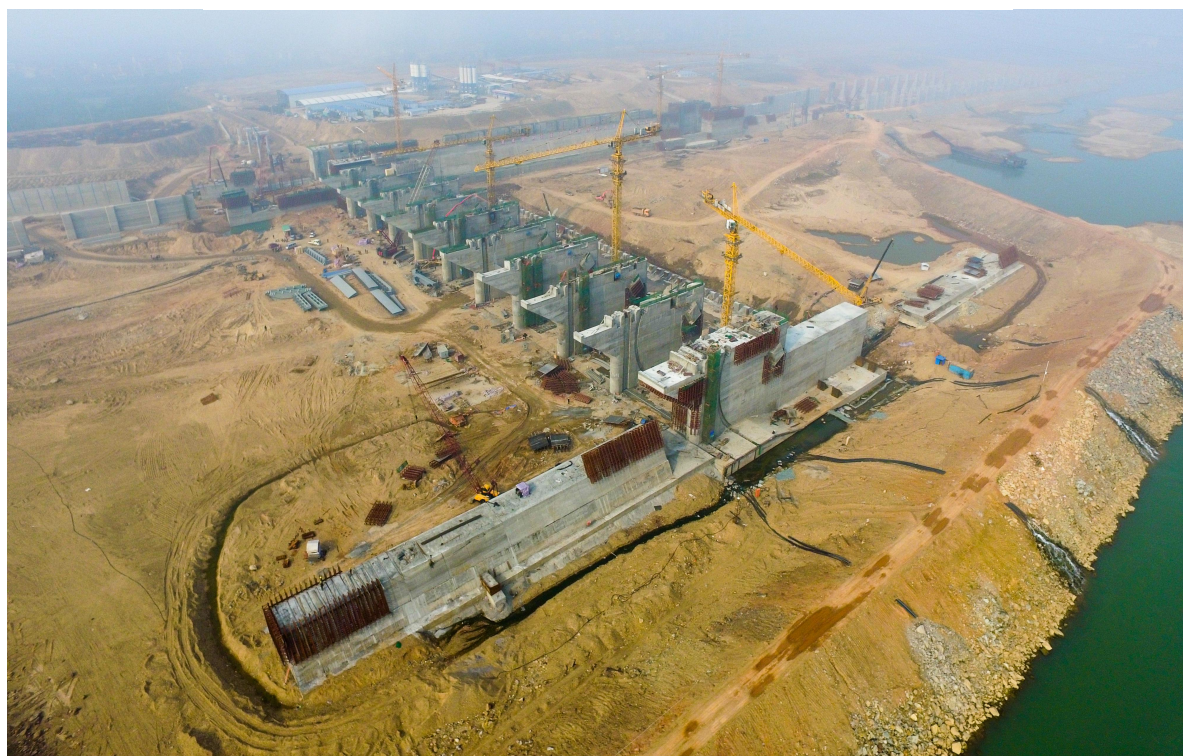
9.5孔泄水闸、船闸全景
