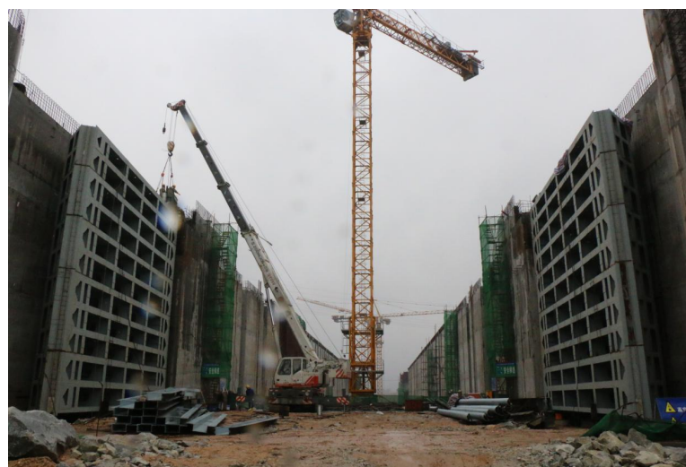
船闸上闸首人字门吊装完成
