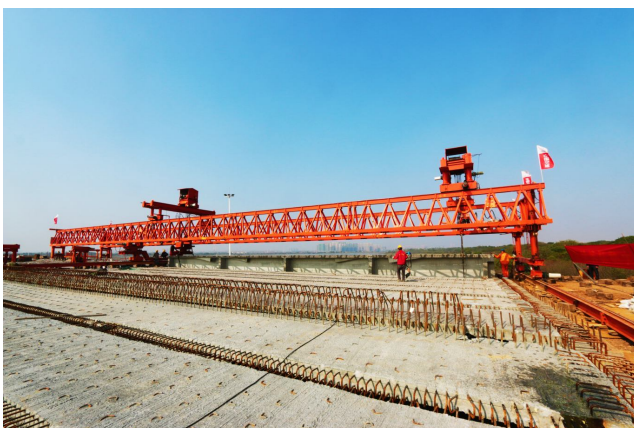
11月12日, 青菱湖大桥808樁T梁架设完成, 该桥长1320米。
