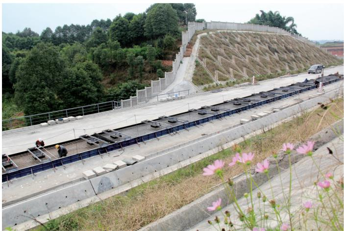
**本报讯** 2016年11月3日,我国西南地区首块CRTSIII型板式无砟轨道先张法预应力混凝土轨道板完成自密实混凝土浇筑,顺利落户中交二航局承建的成贵铁路4标。
