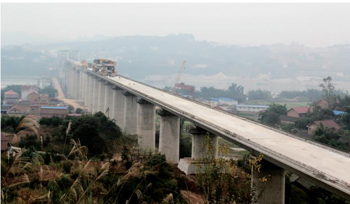
梁施工。屏山制梁场所采用的架桥机则是二航局首台900吨箱梁运架一体机,避免了频繁拆装设备过隧,提高了运架效率。
