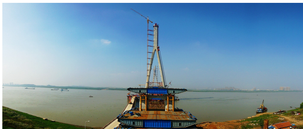
图一 封顶后的主塔
