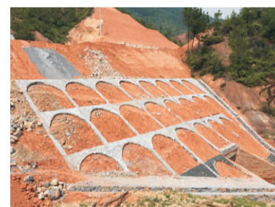
三工区下路堤拱形骨架施工
