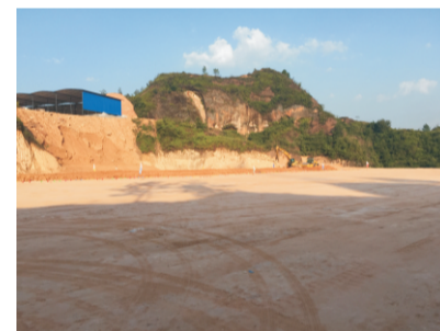
三工区路基土石混填试验段
