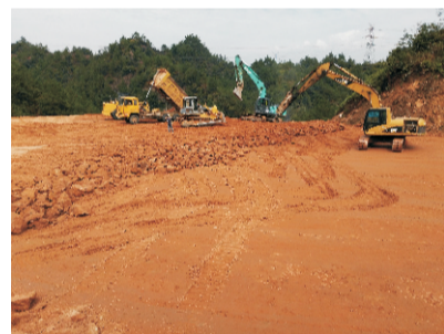
恩施停车区土石方回填施工
