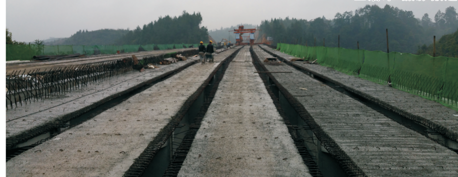
▲银沟2#大桥全桥贯通
