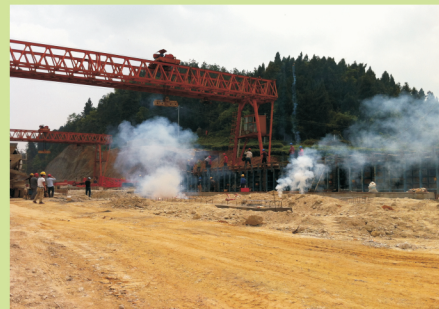
▲图为首片T梁浇筑
