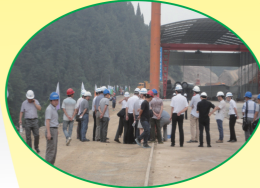
▲ 图为中国交建对施工现场进行检查
