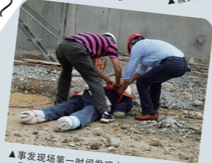
▲ 事故发生第一时间发现人及管理人员解开伤者身上安全带及衣服口袋物件
