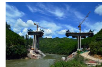
河坝涟江大桥
