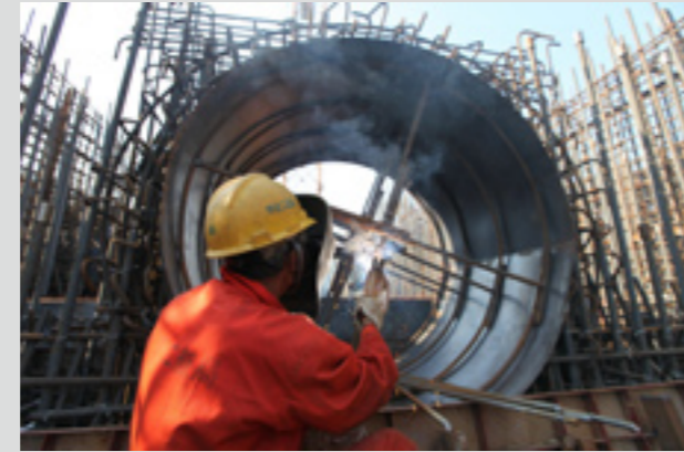
8#墩0#块人洞模板安装固定
