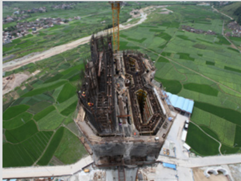
7#墩中塔柱施工
