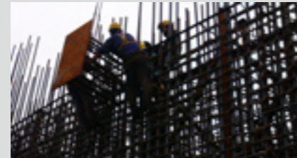
8#墩B横梁埋件安装
