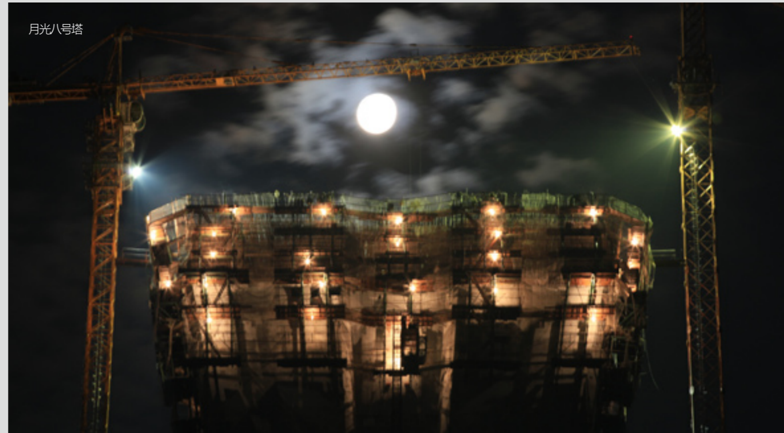
8#墩B横梁支架焊接安装
