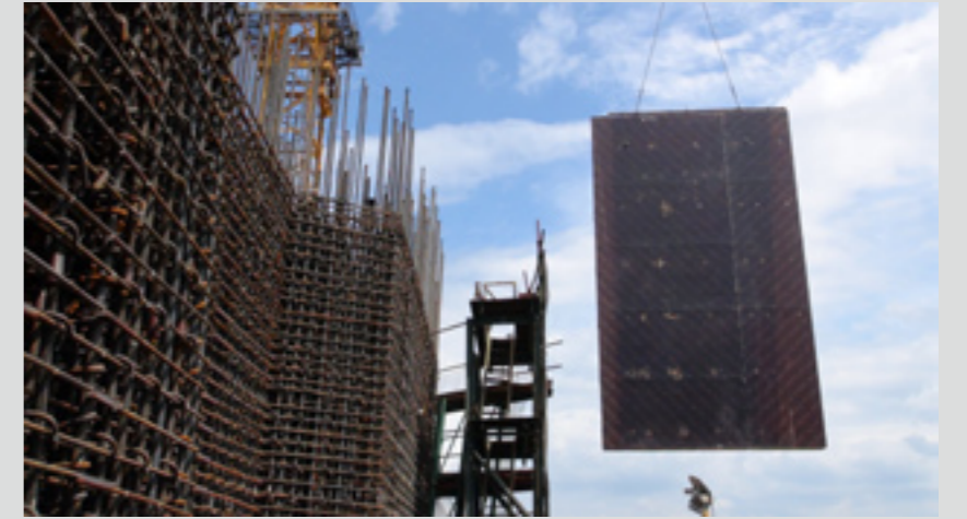
8#墩中塔柱模板安装
