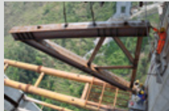
8#墩A横梁支架安装
