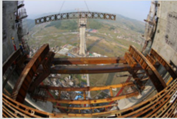
8#墩A横梁支架贝雷片安装
