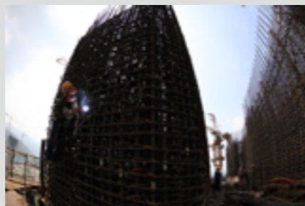
7#墩中塔柱钢筋焊接
