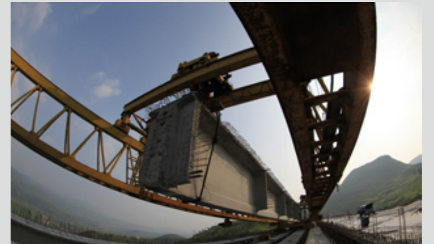
引桥T梁架设
