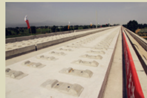
已施工完的无砟轨道
