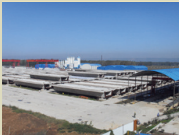
岐山制梁场全景
