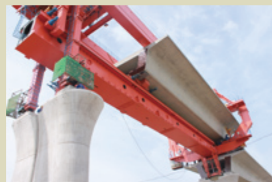
先架方向最后一榀箱梁架设
