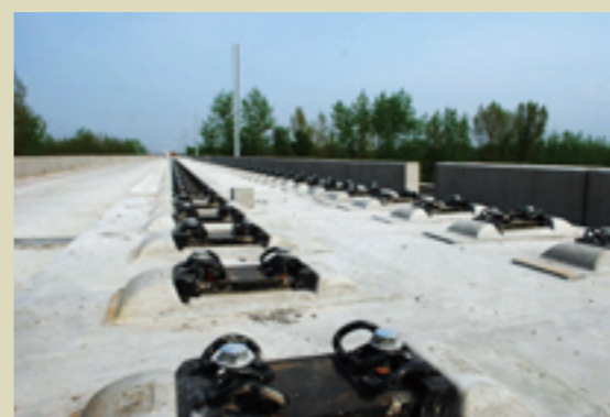
无砟道床施工
