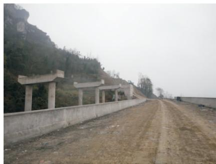
左幅共计完成护栏达720余米，钢筋加工与绑扎共35吨，混凝土110余立方。全桥施工难度不大，由于缓和线段半径大且尾部处于直线段上，使得施工较为简易。鉴于此情况，为了施工方便我们采取10米一间距来控制线性和高程。既方便测量定位，也大大提高精度，确保了质量。
