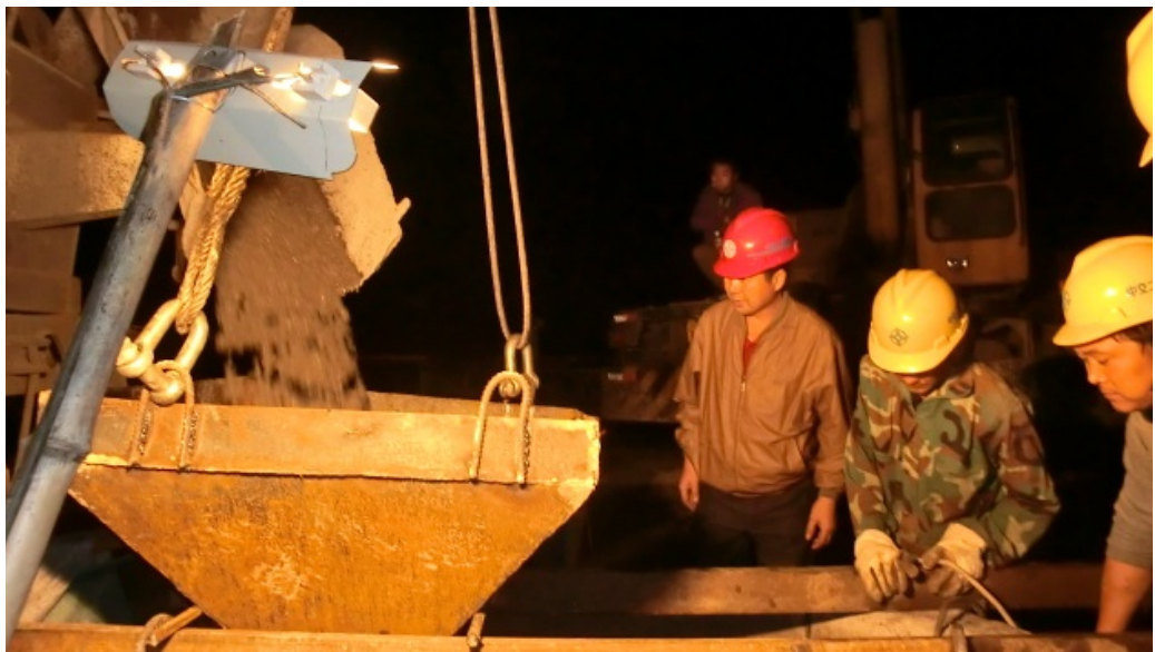
孔桩施工。响了桥梁下构施工的冲锋号,极大地鼓舞了项目部全体员工的参战决心,为下阶段施工奠定了坚实基础。
