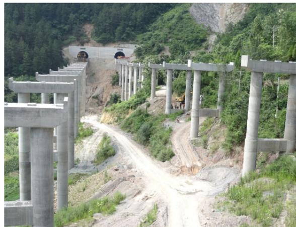
桥台4个，两岸桥台位于陡斜坡地带，桥区中部覆盖层较厚，两岸地形纵坡较陡。燕子岩2#大桥下部构造的顺利完成，标志着上部结构的施工工作全面展开，也为我部后续架梁施工提供了有利保证。
