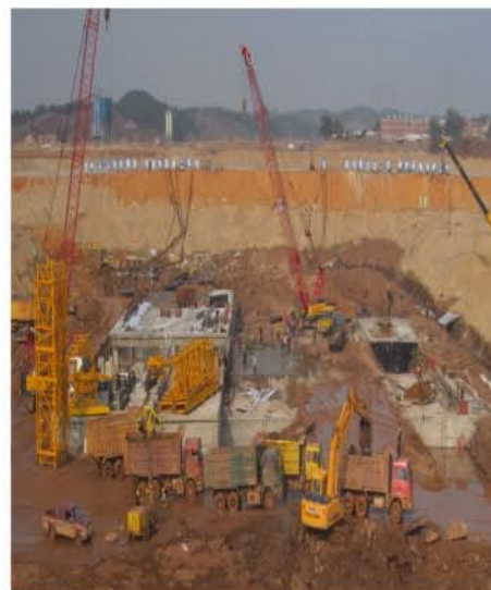
石虎塘工地掀起施工生产高潮
