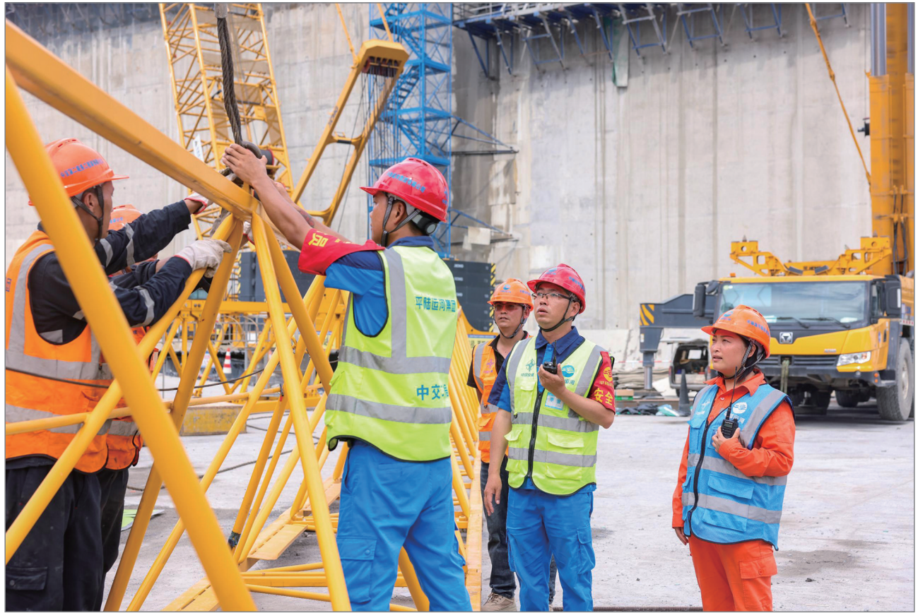
平陆运河马道枢纽项目起重指挥员正在下达起重作业指令。 杨怀鹏 摄影
