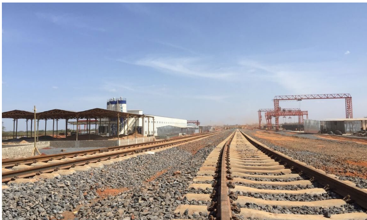
在建的标轨铁路
